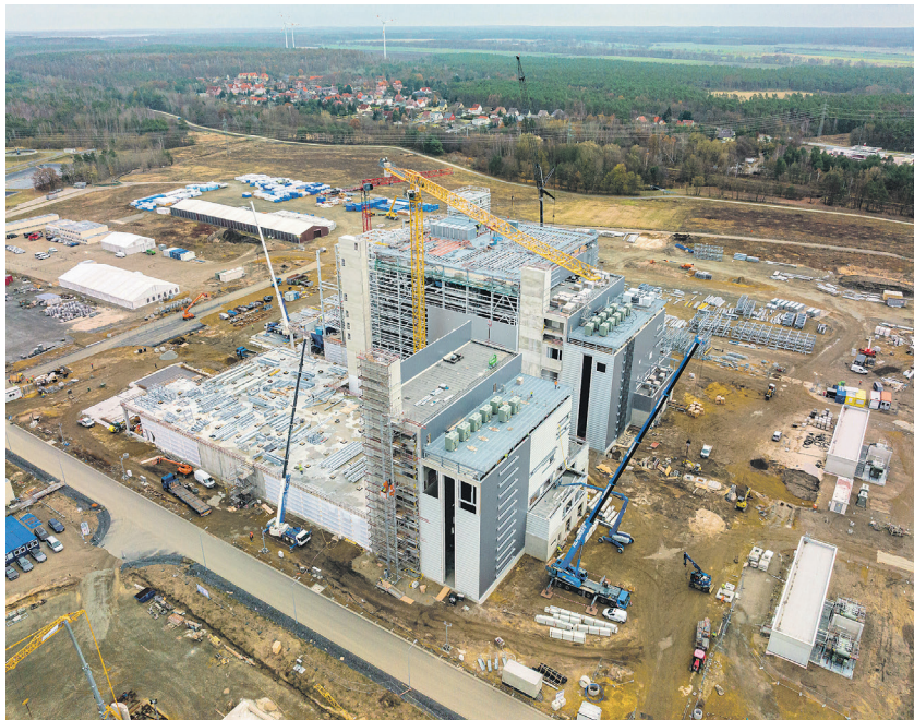
Am Brandenburger BASF-Produktionsstandort in Schwarzhäide wächst eine neue Anlage zur Herstellung hochmoderner Kathodenmaterialien für die Elektromobilität in die Höhe. Die Inbetriebnahme ist für 2022 geplant.
